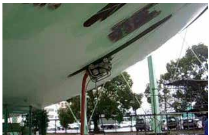
Удаление покрытия присасывающимся модулем, макс. давление 250МПа, подача 30 л/мин.
