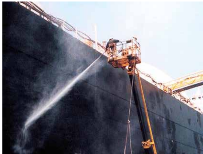
Зачистка корпусов резервуаров от наростов с макс. давлением 12МПа. При зачистке поверхности судна от краски макс. давление от 180 до 250МПа, в зависимости от типа краски.
